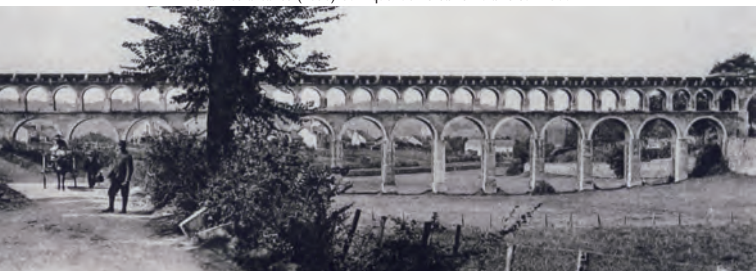
4 - Grandes arcades (1836) ou Aqueduc de Saint-Aulaire sur 2500 m
