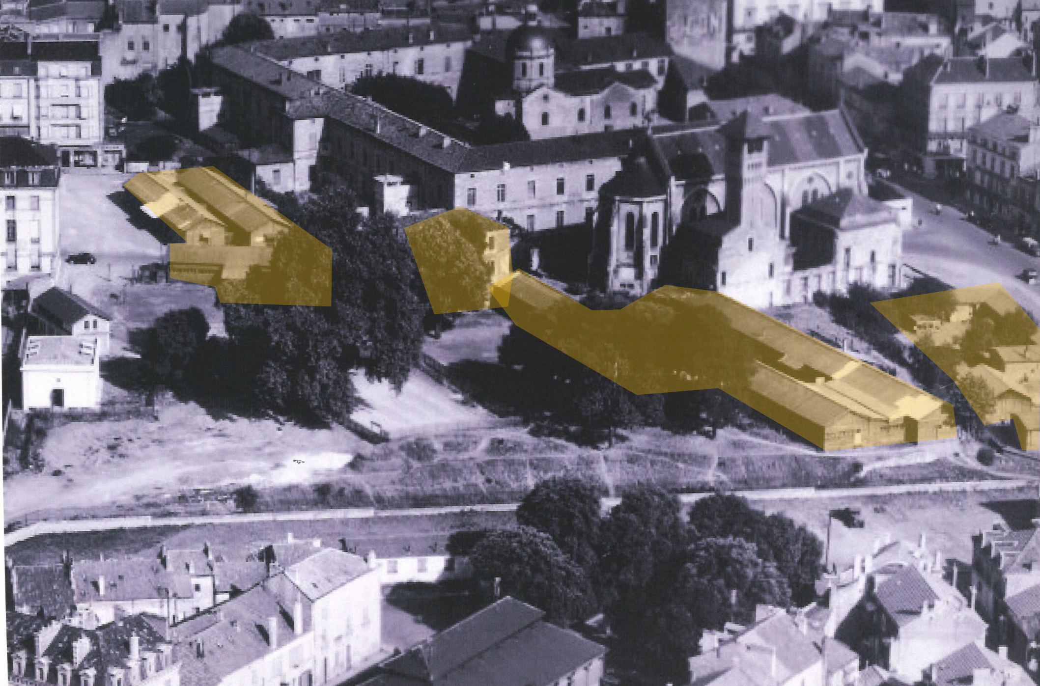
L'immeuble Véchembre (ancienne Bourse du Travail), au coin des rues Antoine Gadaud et du Président Wilson, et la « Maison carrée » dans le parc Jean Jaurès, près de la Poste, sont mis à disposition de l'administration municipale de Strasbourg. En août 1939, il est le premier siège de la mairie de Strasbourg pendant 3 semaines. Marcel-Edmond Naegelen y représentait le maire de Strasbourg.
