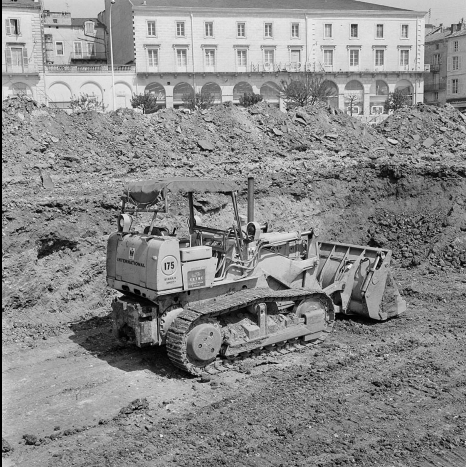
La municipalité décide de construire un parc de stationnement souterrain en 1969. A cette occasion, les travaux permettent de découvrir un puits et les traces des anciennes carrières de pierre. Ici, les terrassements par l'entreprise Balout frères. © Fonds Diaz, 14 Fi / AD24
