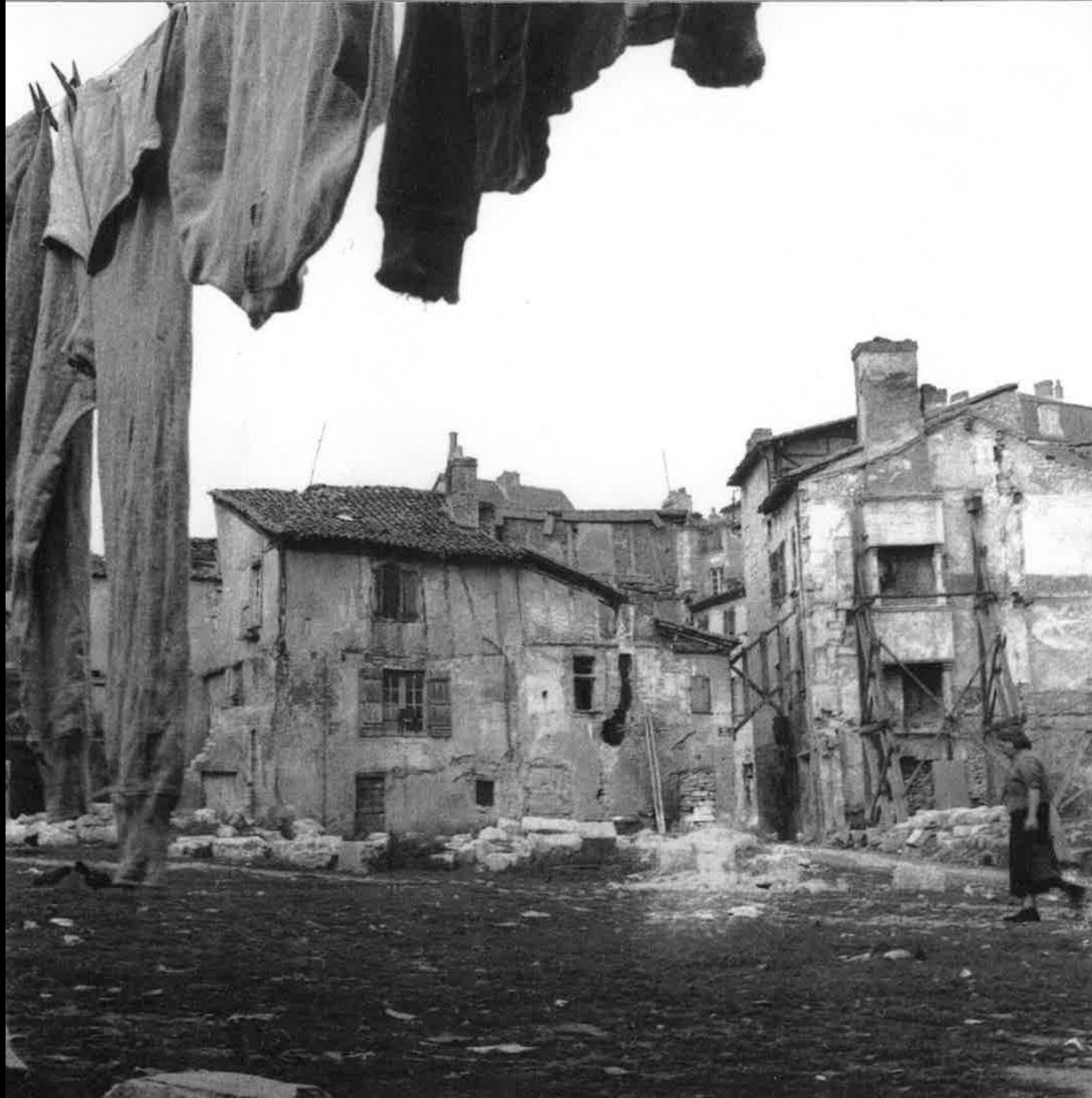
Cette démolition s'étale des années 1950 à 1970. © Jacques Lagrange
