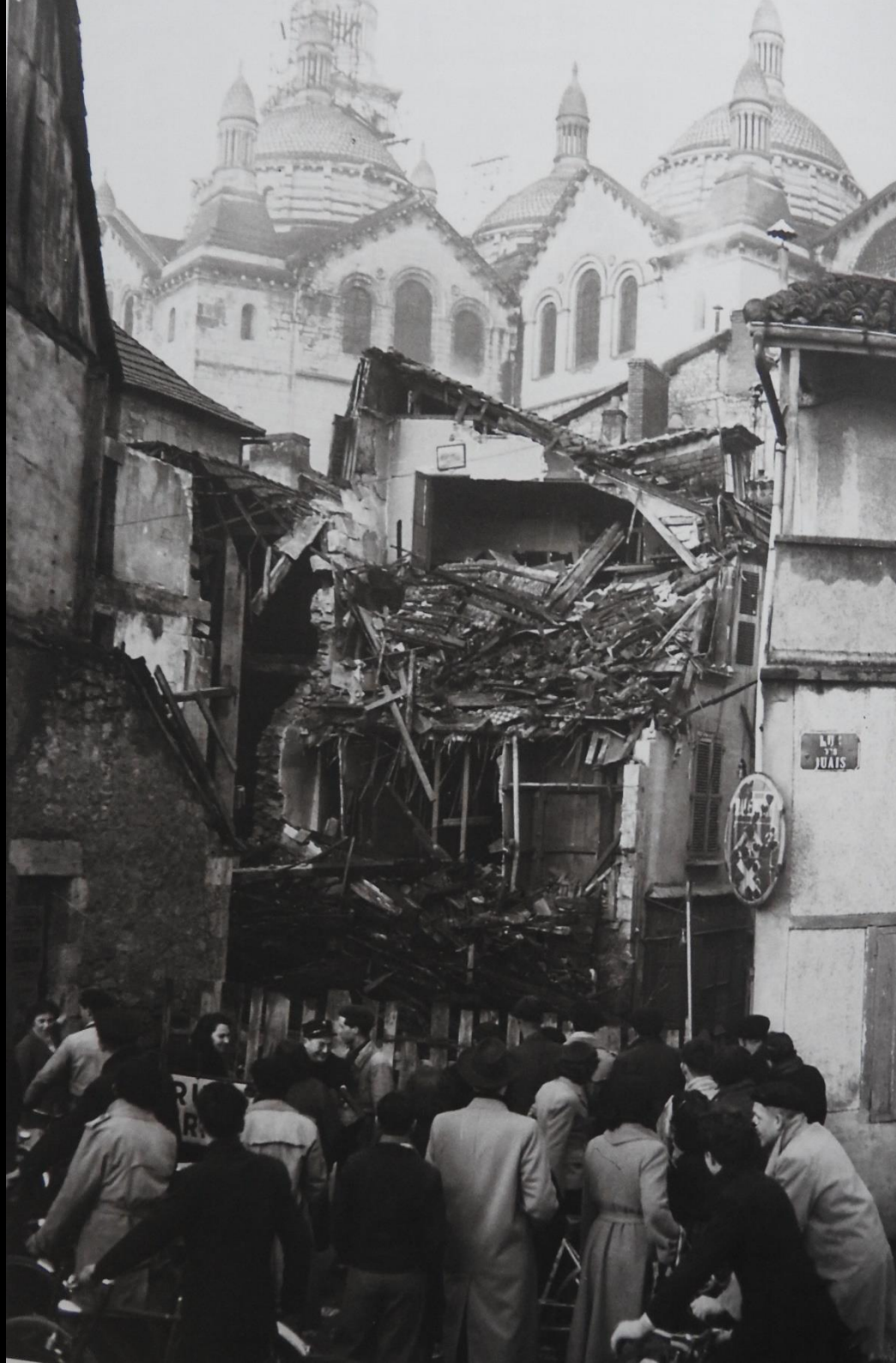
Cette démolition s'étale des années 1950 à 1970. © Jacques Lagrange
