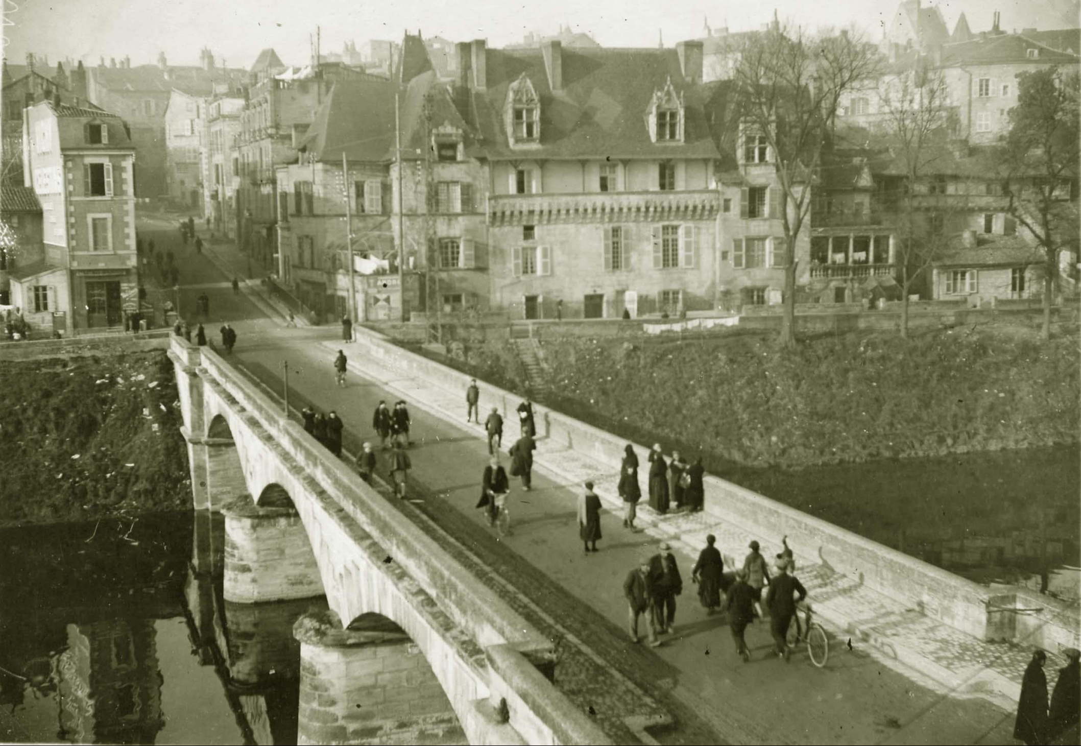
Élargissement du Pont des Barris en 1963. © AD24
