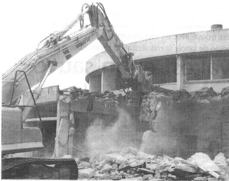
Chantier. Une pince géante à l'œuvre hier
