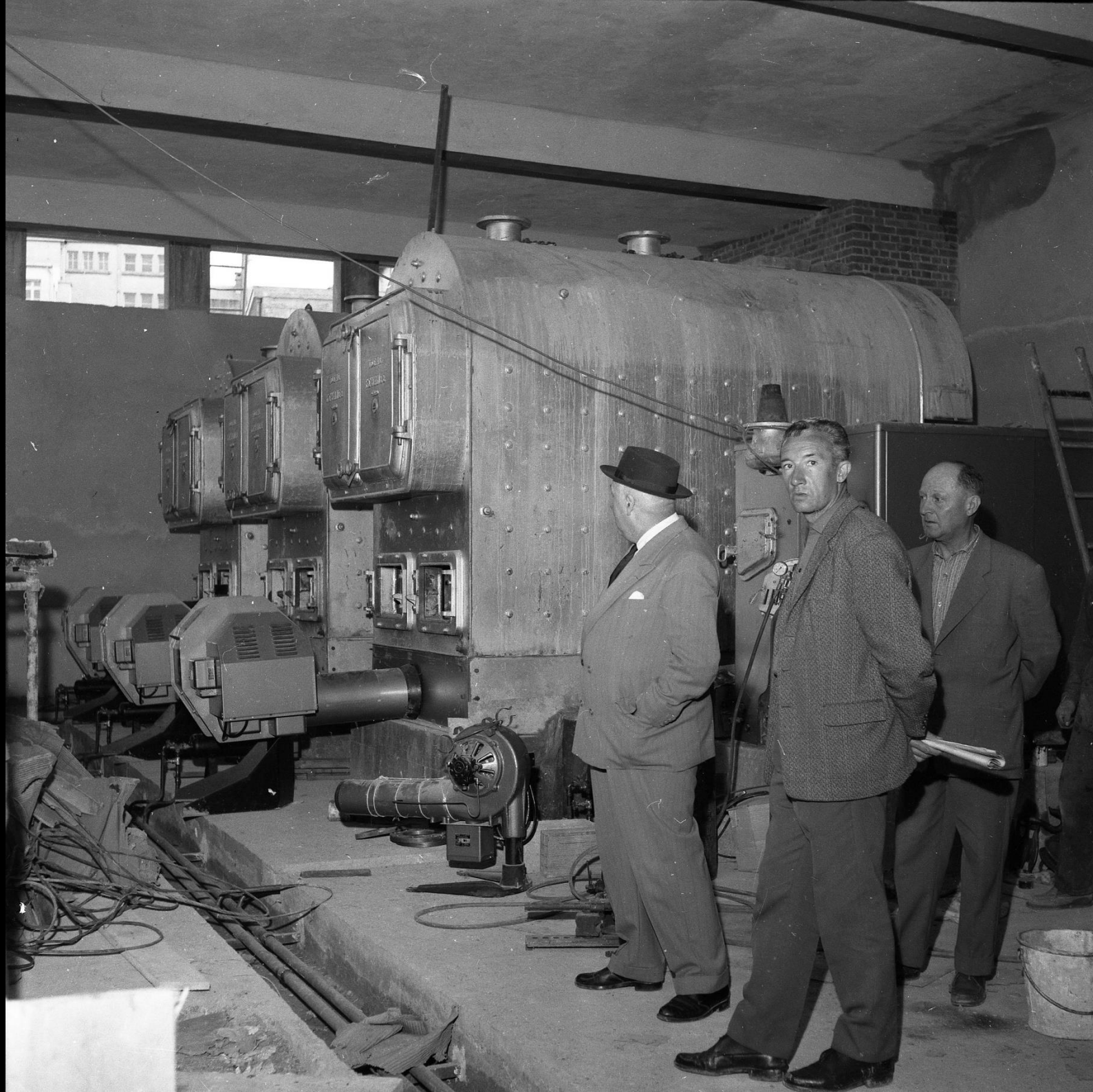
Yves Bancon contrôle les travaux. 1961. © Fonds Diaz, 14 Fi / AD24
