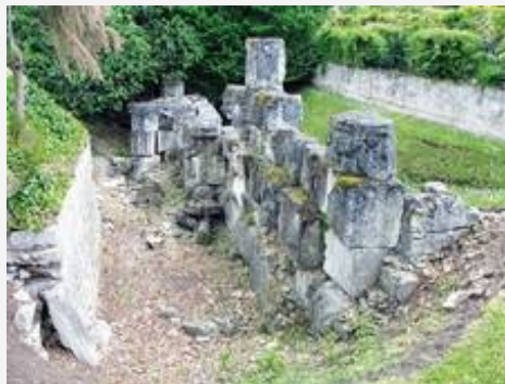
Les vestiges du rempart, rue Romaine
